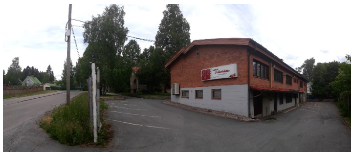
Kuva 4. Suunnittelualueen punatiilinen teollisuusrakennus © Tampereen kaupunki 2019.
